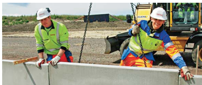
De blivande anläggningsingenjörerna Nicklas Hellberg och Alexander Lindoff sommarjobbar i Hyllie där Inre Ringvägen byggs ut. Det är viktigt att L-stöden som ska markera körbanans mitt får en exakt radie.
